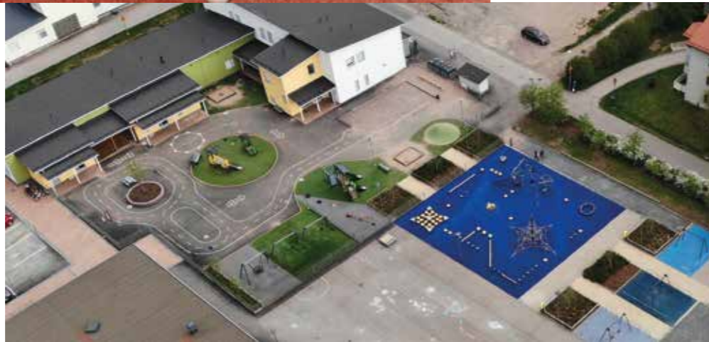
Mestari-toiminta Oy rakennuttaa ja hoitaa Mestariasuntojen talojen ja allianssisopimukseen kuuluvien, Järvenpään kaupungin omistamien kiinteistöjen pihvoja. Kuvassa Saunakallion päiväkodin piha, joka on uusimpia rakennutettuja kohteita.
